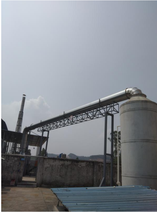
生产车间废气处理措施（“水喷淋+干式过滤+活性炭吸附+脱附催化燃烧”装置）
