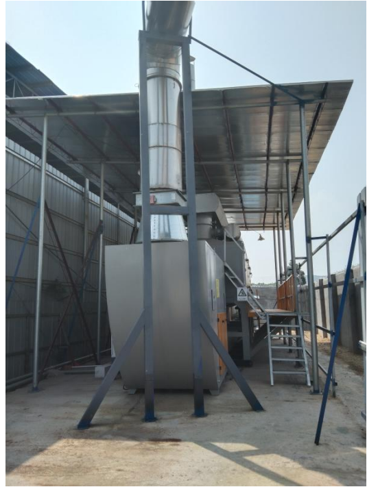
生产车间废气处理措施（“水喷淋+干式过滤+活性炭吸附+脱附催化燃烧”装置）
