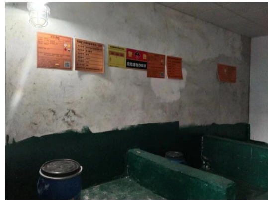
危险废物仓内部防渗图片
