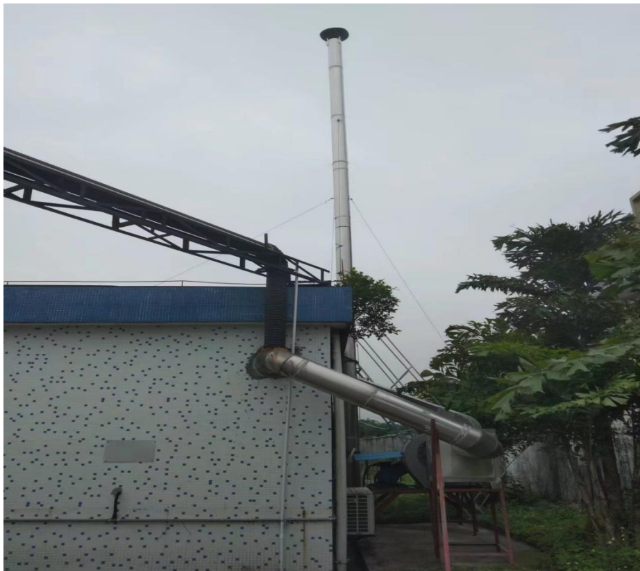
实验室废气处理设施（活性炭吸附装置）和排气筒（DA002）
